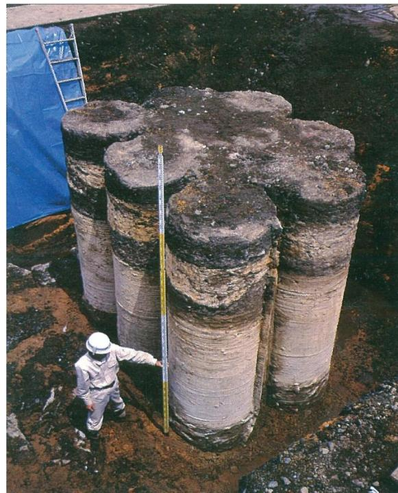
支持層が1～10メートル程度の原地盤に改良材などを混ぜ合わせながら硬い地盤に変えていく工法
