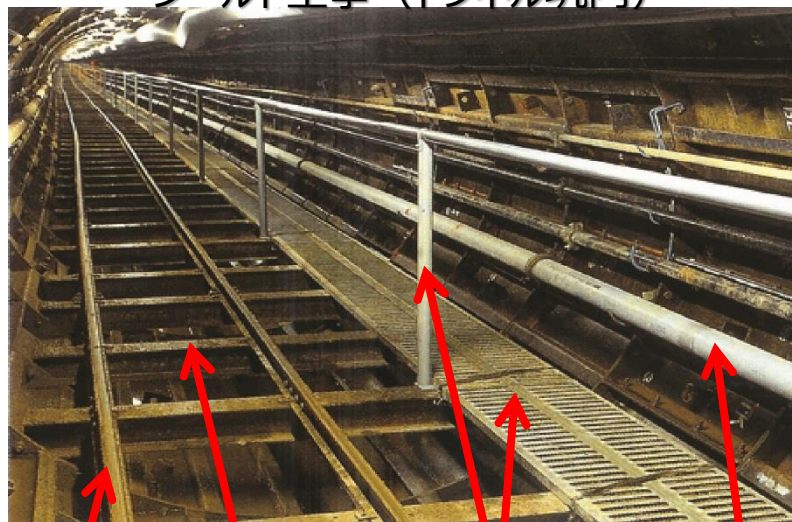
シールド工事（トンネル坑内）
