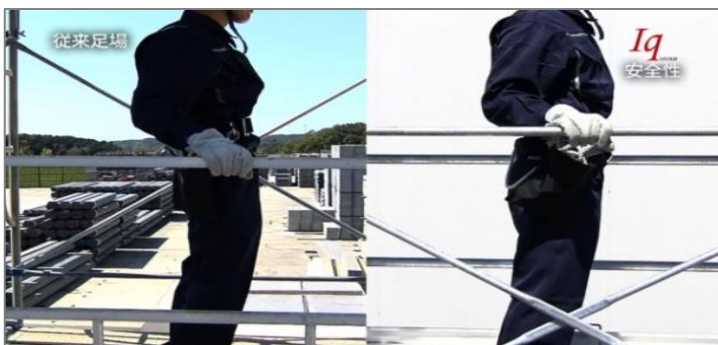
写真左「従来枠組足場」
