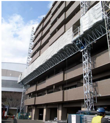
昇降式足場工法 (リフトクライマー)
