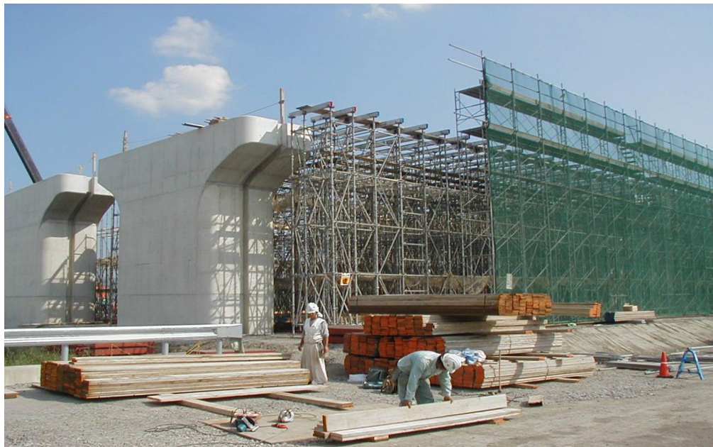
↑ 橋梁上部工（ハイパー）
