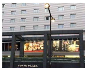
建物2階部分に広告用の懸垂幕を設置 (東急プラザ赤坂)
