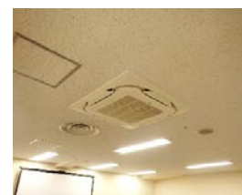
地下1階個別空調化 (大阪中之島ビル)
