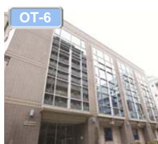
湯島ファーストジェネシスビル
