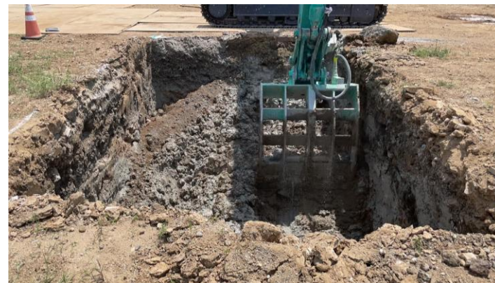
テノキューブ施工写真
