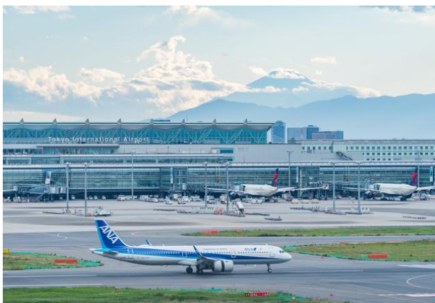
空港施設：TN-X工法,NSエコパイル工法
